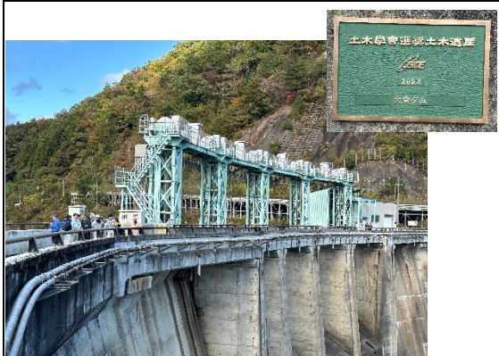
大倉) 堤体上部にて (クレストゲート
