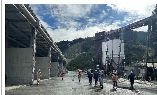
川内沢) コンクリート製造設備ヤード
